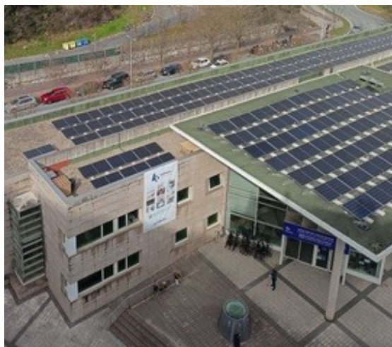
Instalación de paneles en el CS de Amara Berri
