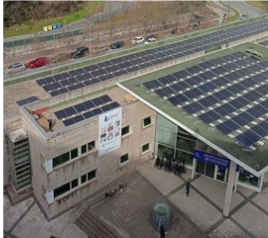
Amara Berriko Osaun Zentroko panelen instalazioa
